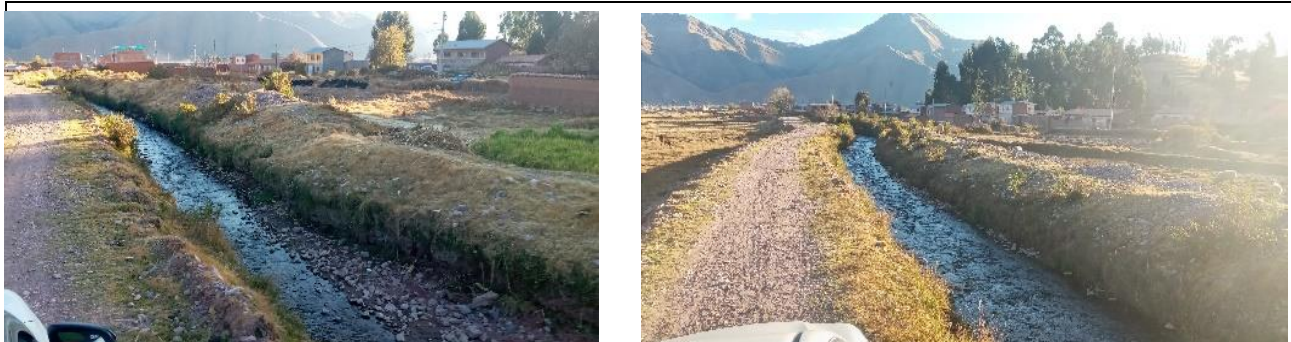
FOTO 01: Cauce del río Ccanccahua identificado punto crítico, estrangulado con talud natural en ambas márgenes, es tributario al río Vilcanota.
